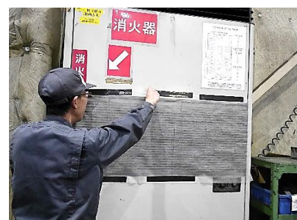
フィルター交換の様子
