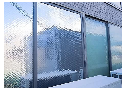
遮熱シート（左）未施工（右）
